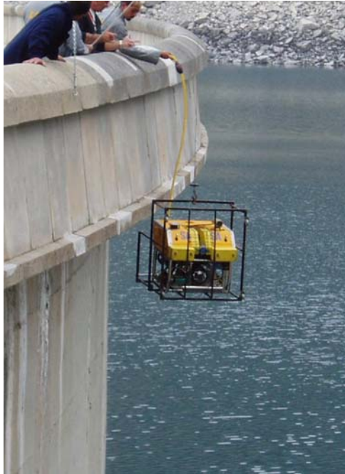
Visite décennale du barrage de Cap de Long – descente du robot subaquatique (juin 2006) Source : EDF
