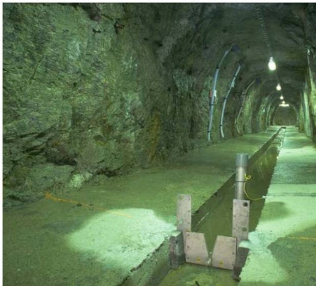
Mesures de débit - Source :EDF
