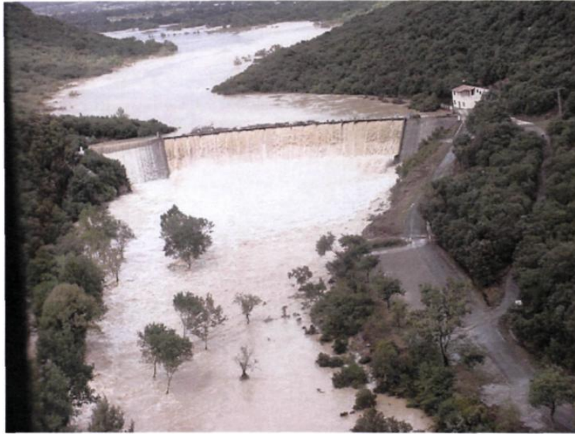
Barrage écrêteur de crue de la Rouvière ( H = 18 \text{ m} , 8,3 \text{ hm}^3 ) lors de la crue du 9 septembre 2002. Ce barrage, construit en 1970, a connu ce jour là une crue supérieure à sa crue de projet de sûreté et s'est malgré cela bien comporté.
