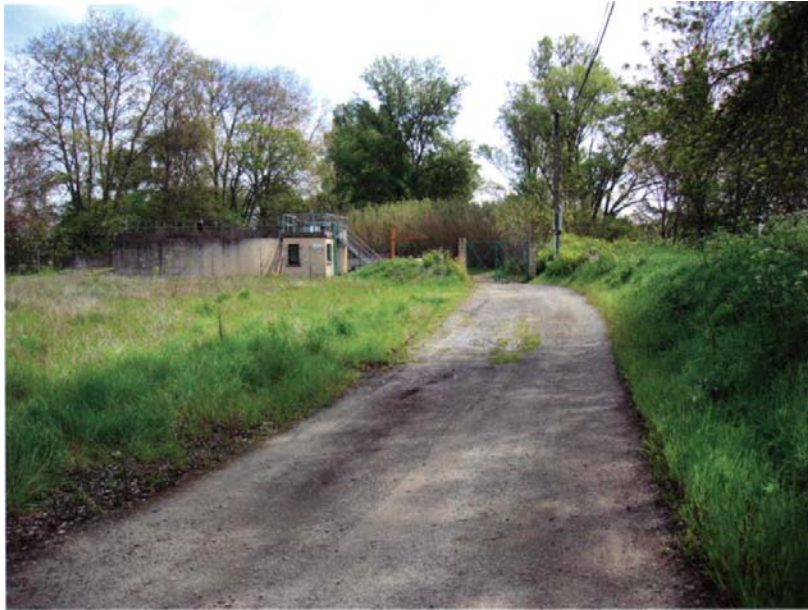
Vue de la station d'épuration au pied de la digue – DDAF11
