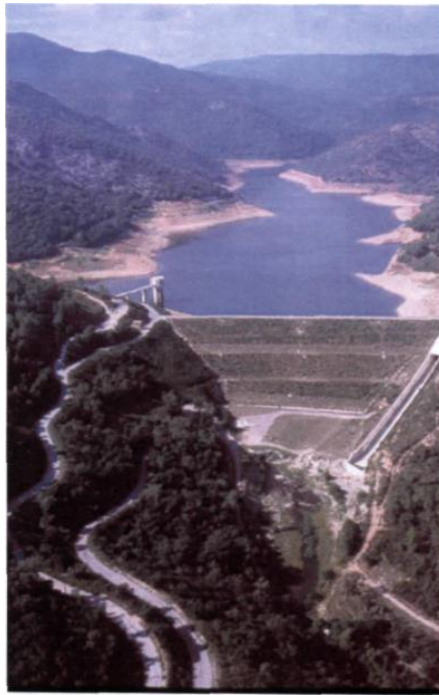
Vue d'ensemble de la retenue de la Verne. Le barrage, H = 42\text{ m} , 8\text{ hm}^3 , dessert en eau potable la corniche des Maures Source : AIGREF n°19
