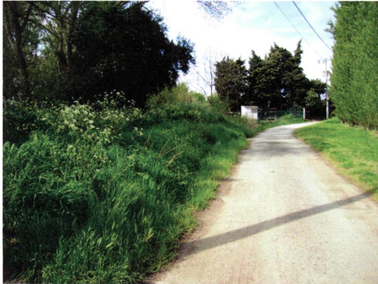
Vue de la digue depuis la station d'épuration - DDAF 11
