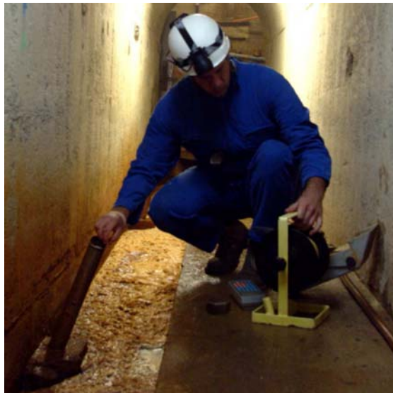
Le piézomètre - Source :EDF
