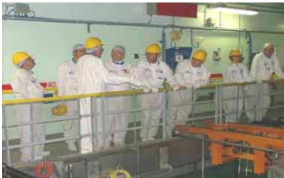
Piscine de refroidissement du CPEN de Gravelines - 10 mai 2007
