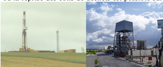
Forages et puits à Bure
